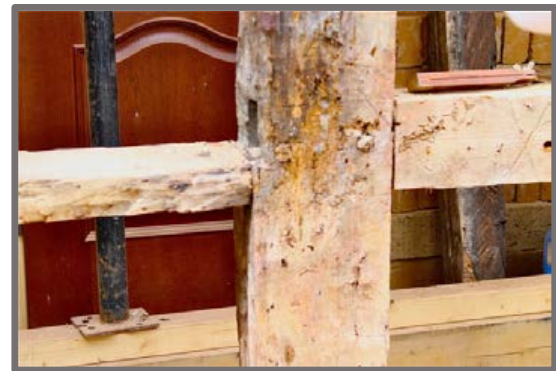
Freigelegtes Fachwerk am Cramerschen Haus, Heilige-Geist-Straße
