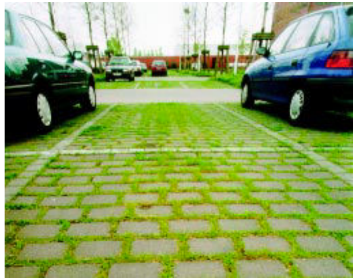
Flächenversickerung am Beispiel einer Parkplatzgestaltung
