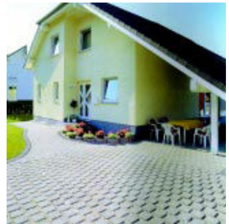
Betonpflaster mit Dränfuge
