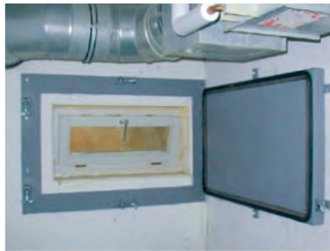
Abbildung 9 Druckdichtes, selbstschließendes Fenster (BMUB, 2016)
