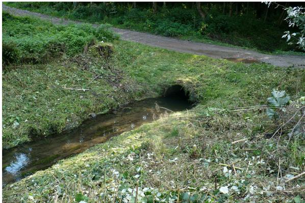
Im **NSG Loemühlenbachtal** erfolgte der Austausch eines als Überfahrt genutzten Betonrohres durch eine Brücke aus Betonfertigteilen im **Loemühlenbach**
