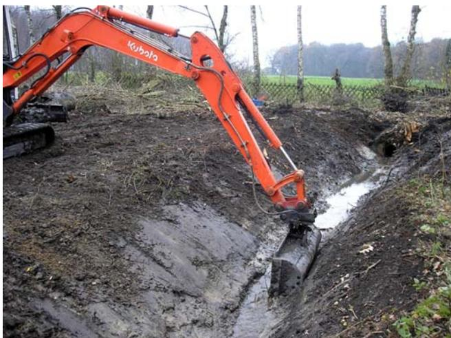
Bagger öffnen den ca. 50 m langen verrohrten Abschnittes des Loemühlenbaches im **Naturschutzgebiet Loemühlenbach**. Dies ist eine zentrale Maßnahme aus dem diesjährigen Umsetzungsfahrplan des Vestisches Umweltzentrum.
