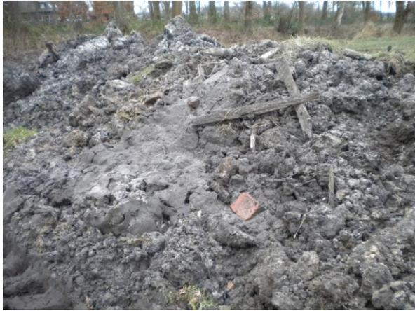
Insgesamt wurden aus den Ufern des Baches 1500 t entnommen. Die Hochofenschlacke war bis zu 1 m tief in die Böschungen eingebaut worden.
