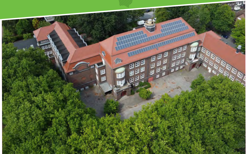
An der Wittringer Schule wurde der Bereich der Offenen Ganztagschule umgebaut.
